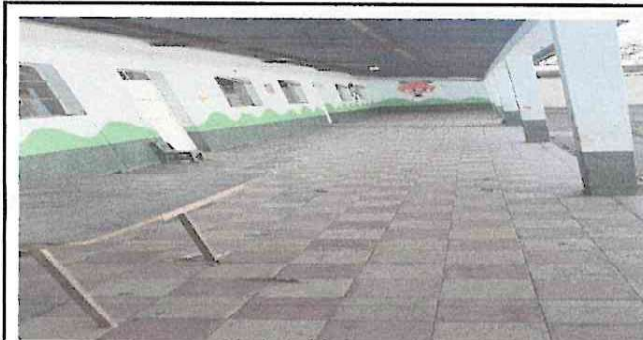
Foto 3: Pintura en muros exteriores
