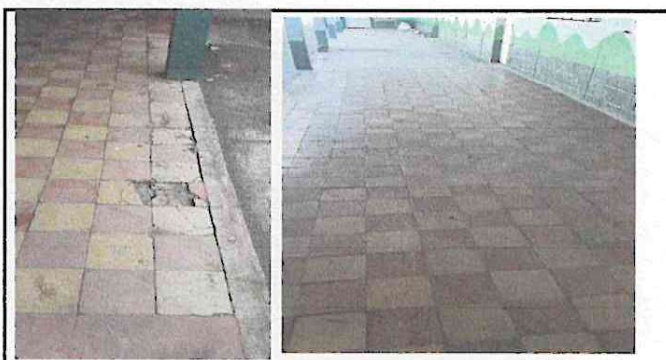
Foto 4: Sustitución de piso en corredor del ala derecho y salon de clases
