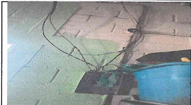
Foto 1: Sustitución de cableado eléctrico en 1 salon y corredor del ala izquierda
