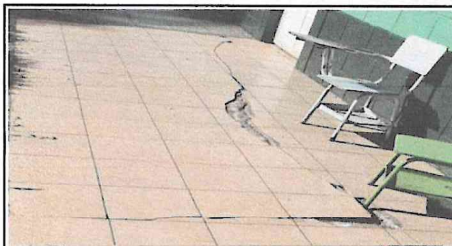
Foto 3: Sustitución de piso Ceramico en corredor del ala derecha
