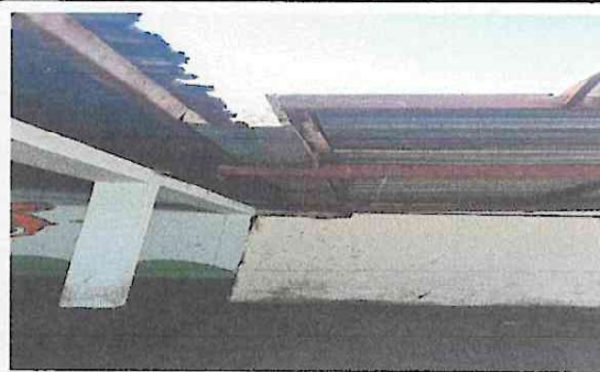
Foto 6: Sustitución de bajada de agua pluvial de metal por tubo PVC 3"
