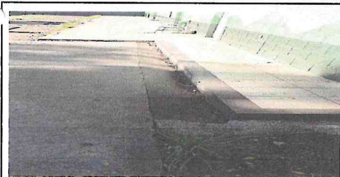
Foto 5: Reparación de cuneta de concreto
