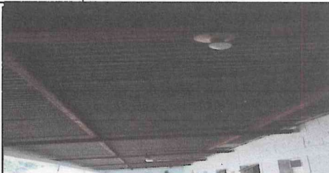
Foto 2: cambio de focos, instalación de cableado electrico en corredor, cambio de plafonera
