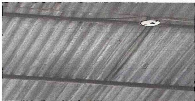
Foto 1: cambio de plafonera instalación de cableado electrico, instalación de focos ahorradores
